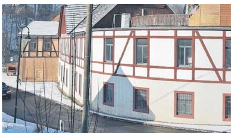
Wird das denkmalgeschützte Areal der Mühle nach dem Tod des Besitzers verkauft? Die Gemeinde hat vorsorglich abgewunken. FOTO: E. MILDNER/ARCHIV
